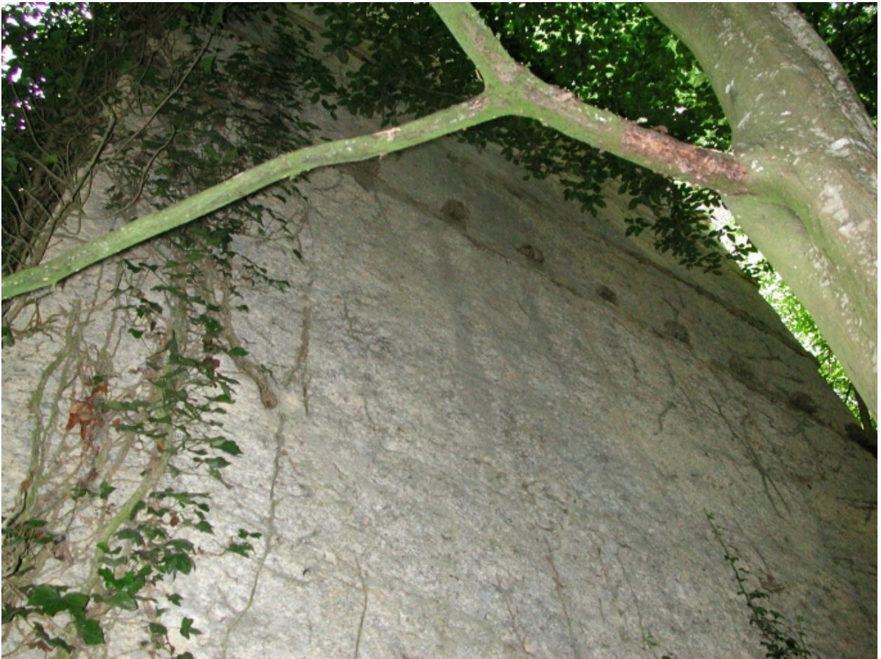
Mur en terre de la tour située au nord ouest du château
