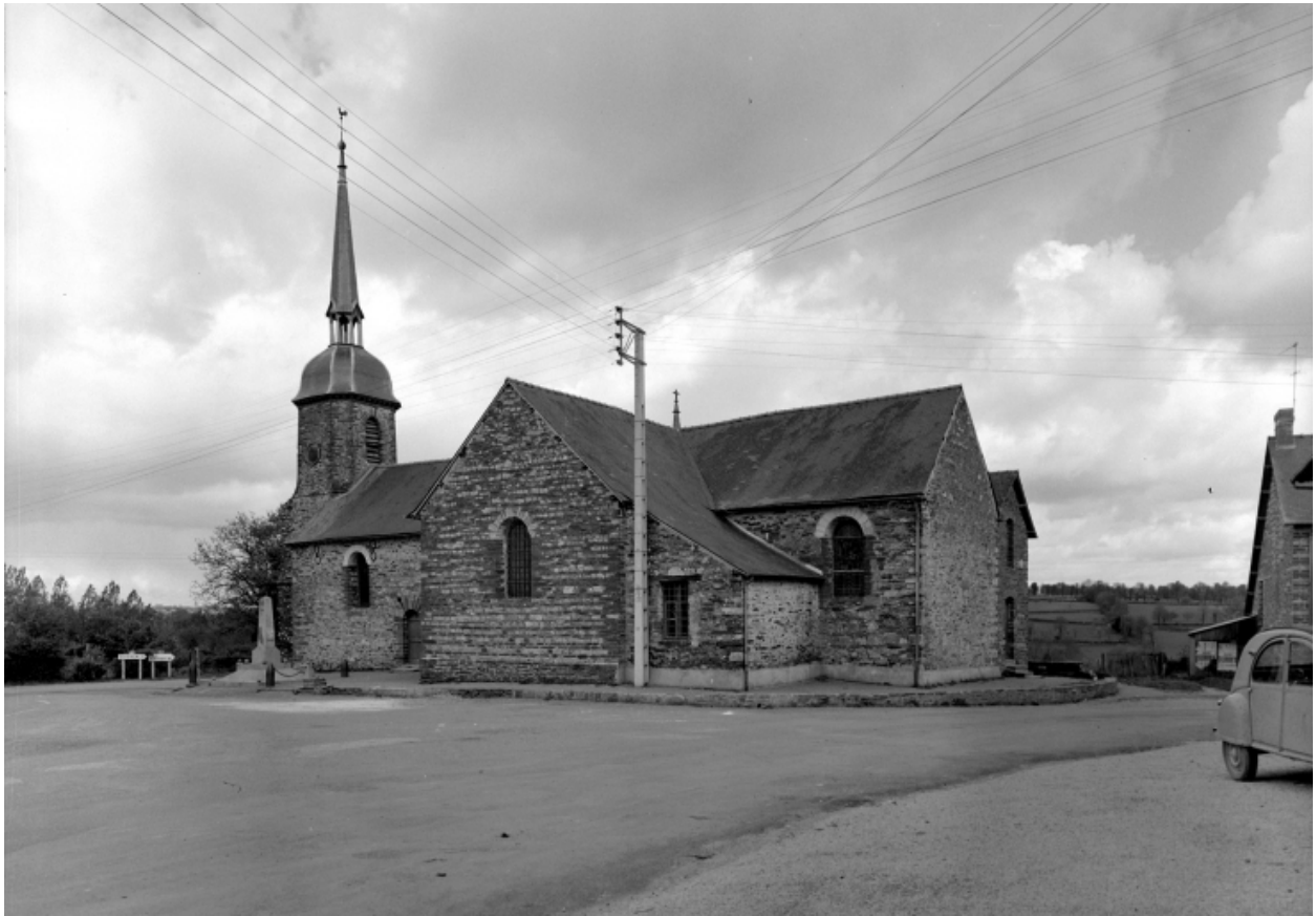
Elévation nord-est : vue générale
