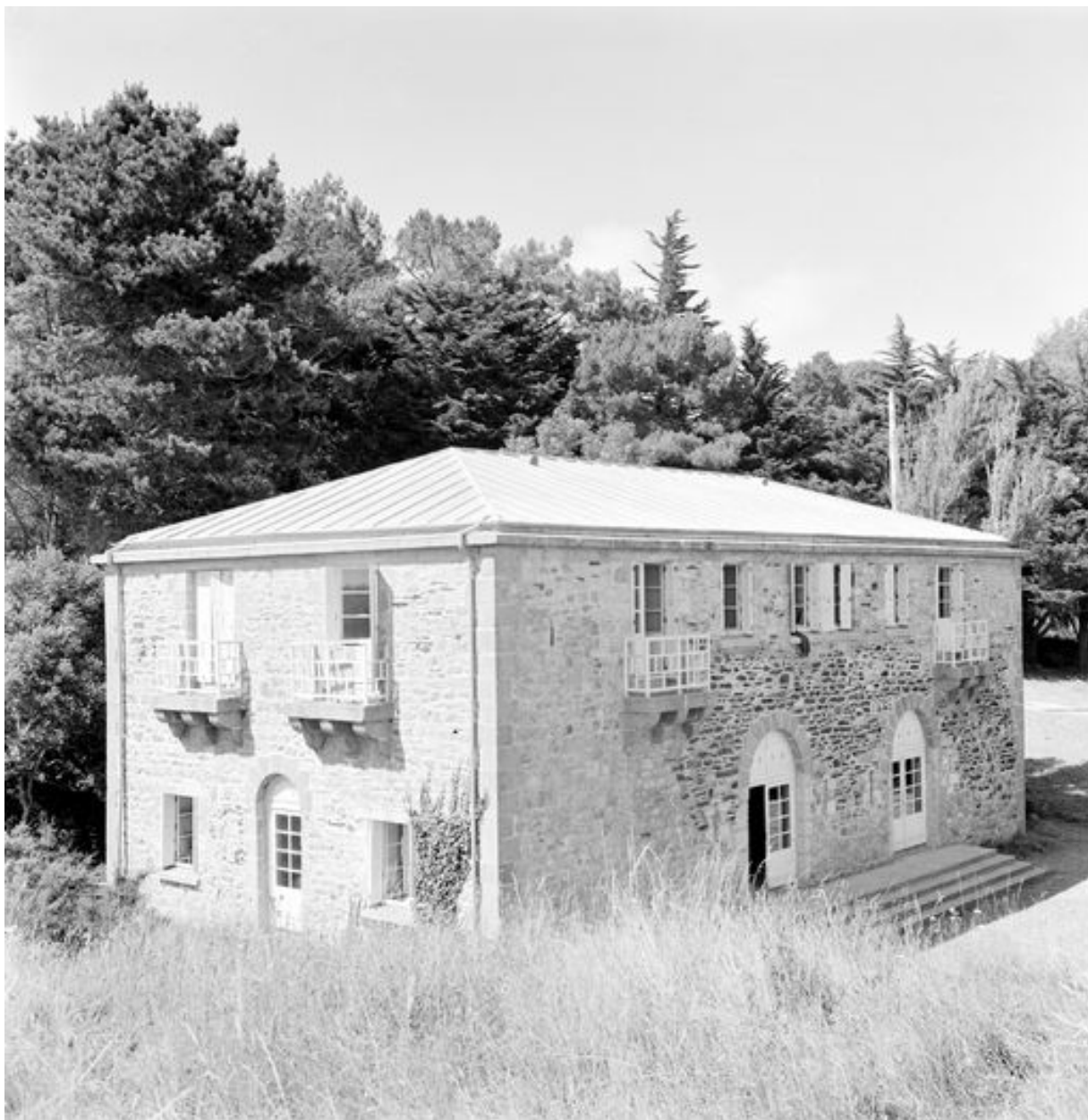
Vue du corps de garde crénelé n° 2 de Postolonnec en 1969
