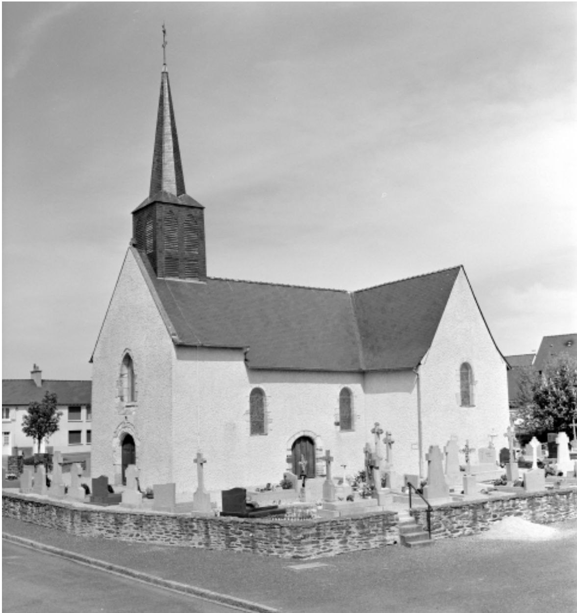
Elévation Sud-Ouest : vue générale
