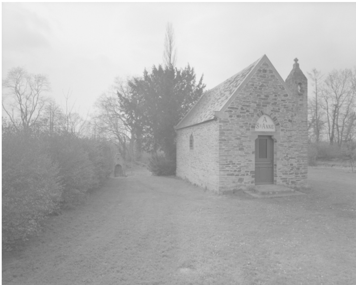
Elévation Ouest : vue générale
