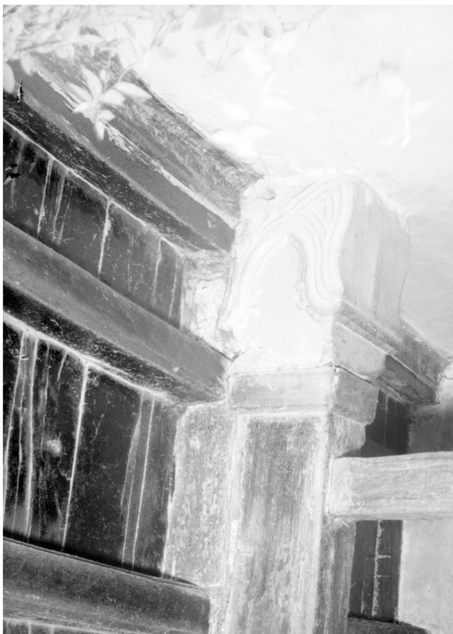
Détail d'une poutre engoulée
