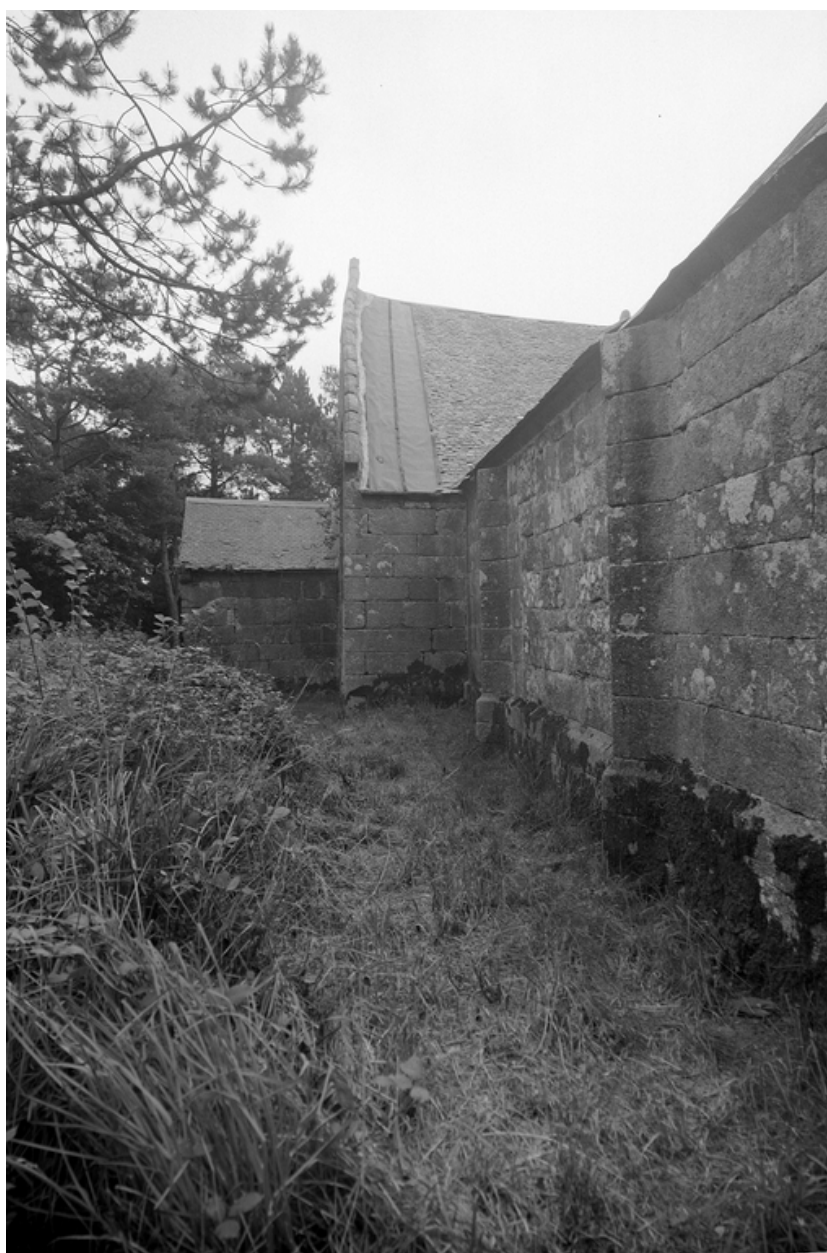
Vue générale prise du nord est
