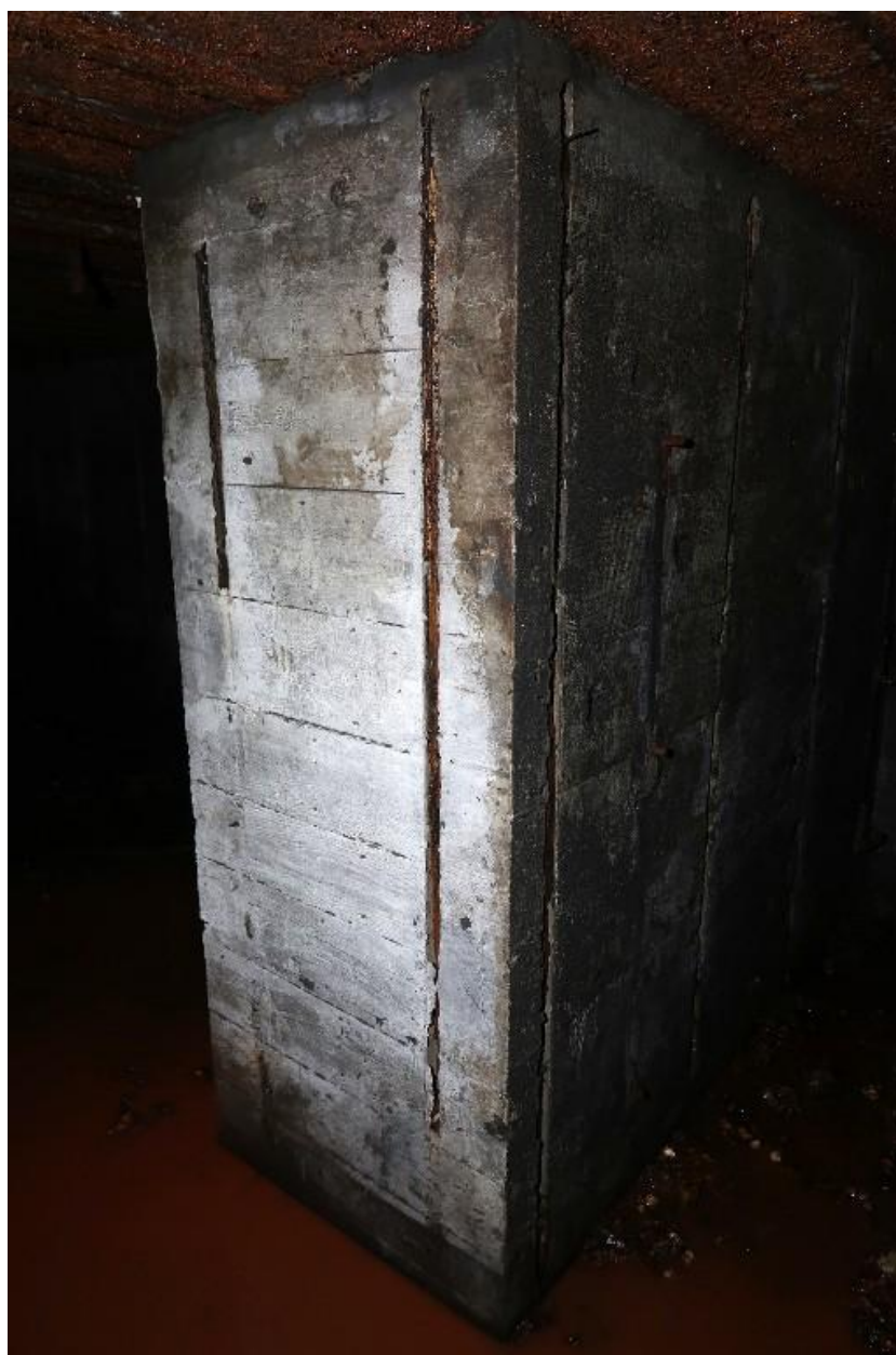
Vue intérieure : mur de refend des salles de garde nord et sud
