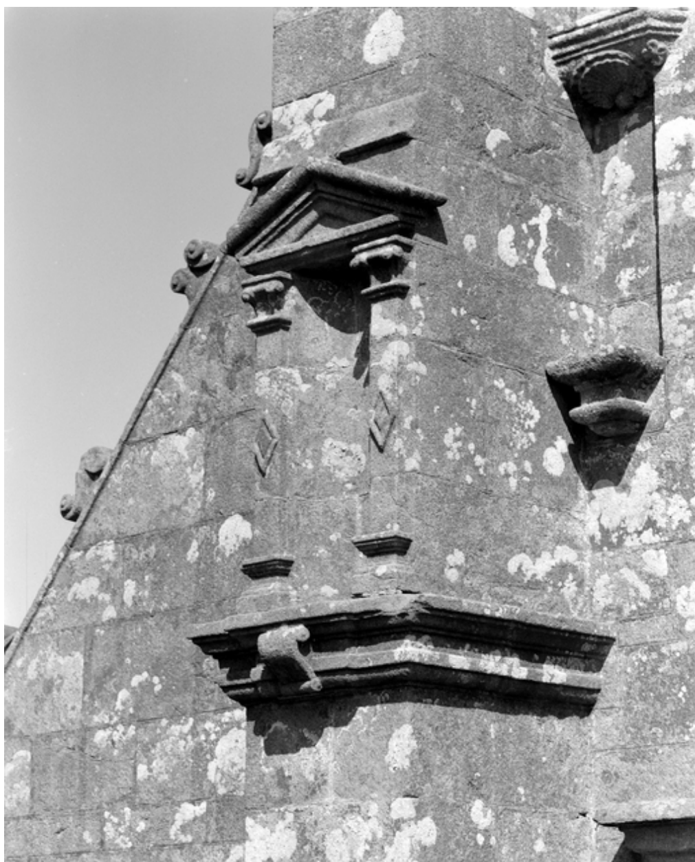
Façade ouest : vue de la niche du contrefort nord
