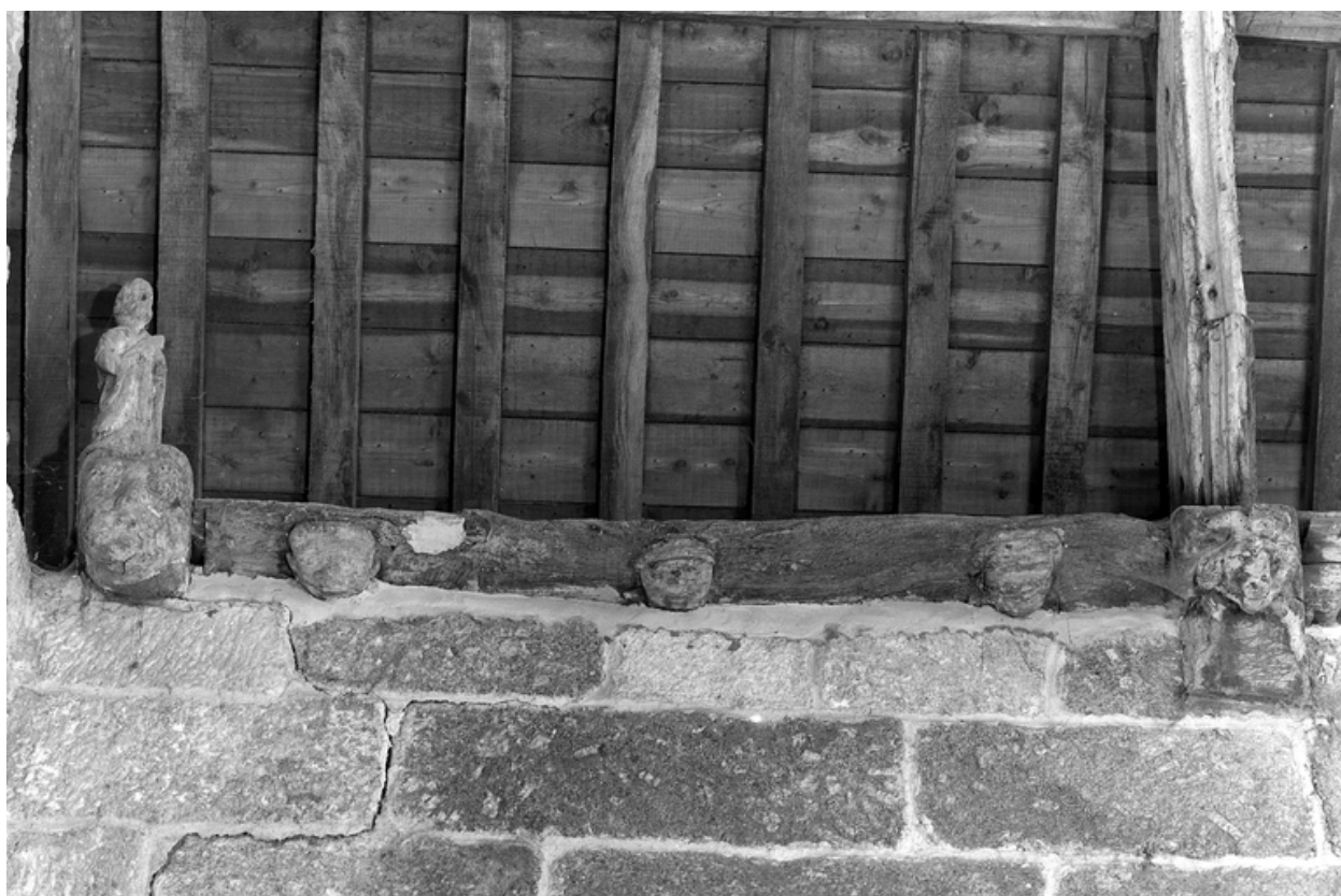
Intérieur, mur nord : sablière, motif I à l'ouest
