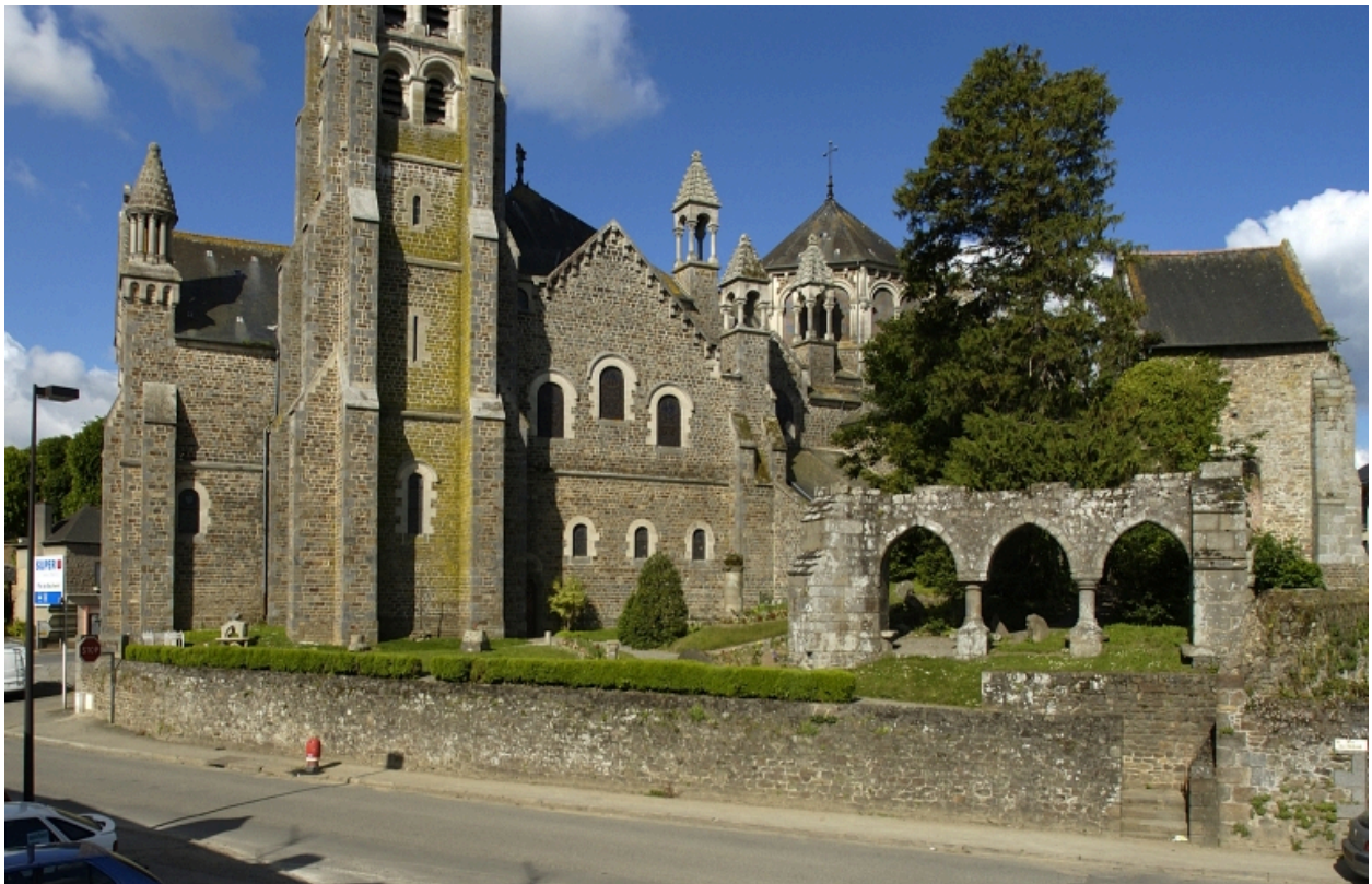
Elévation nord-est et vestiges de l'ancienne église
