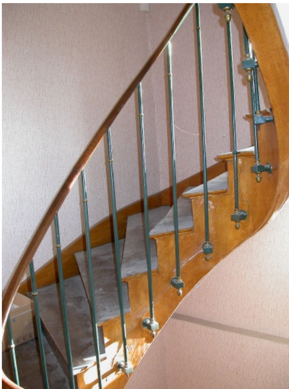
Balustres de l'escalier
