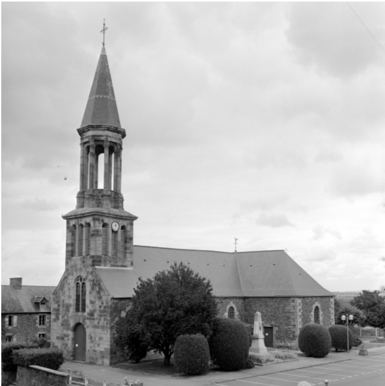
Elévation Sud-Ouest : vue générale
