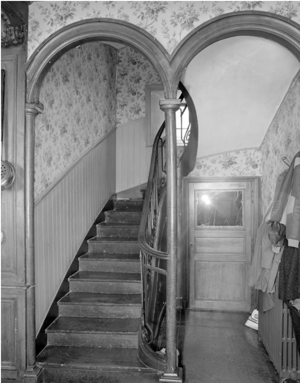
Vue générale du rez-de-chaussée avec l'escalier.
