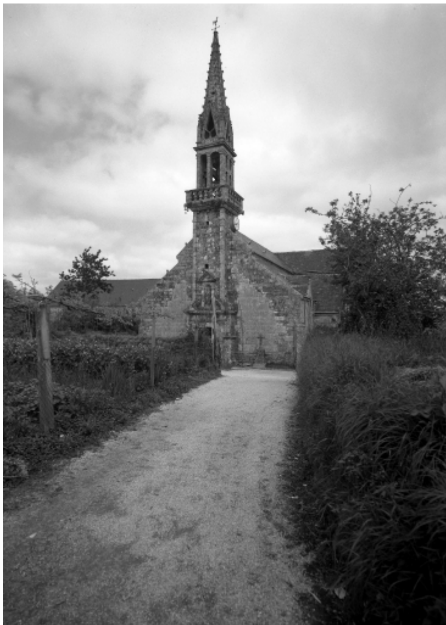
Quéménéven, église paroissiale Saint-Ouen : vue générale ouest, état en 1972
