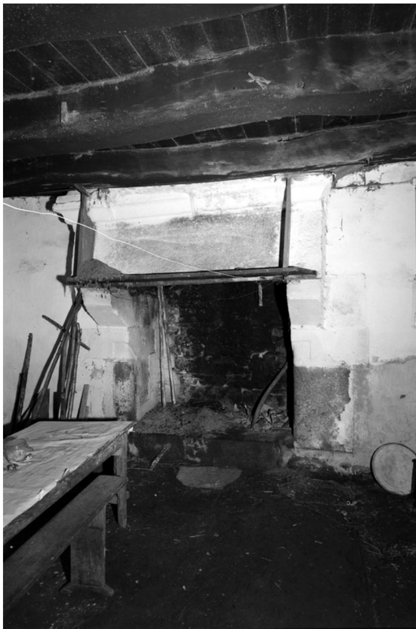
Cheminée de la pièce sud au rez-de-chaussée
