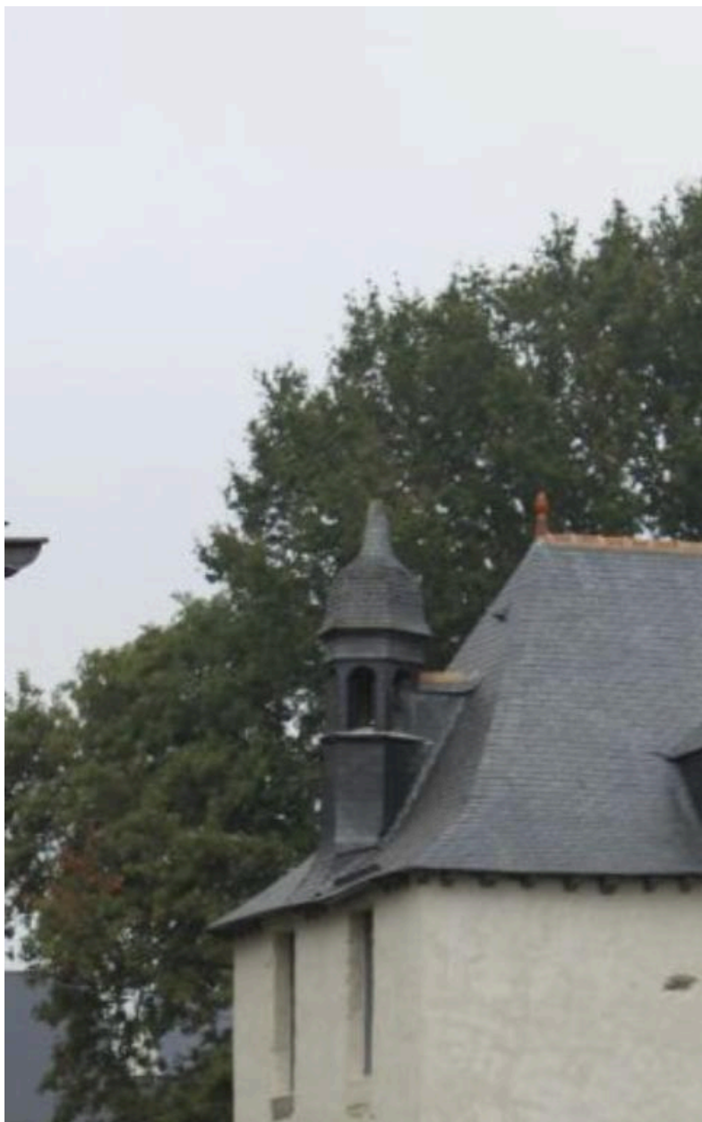
Façade sud : détail du clocheton
