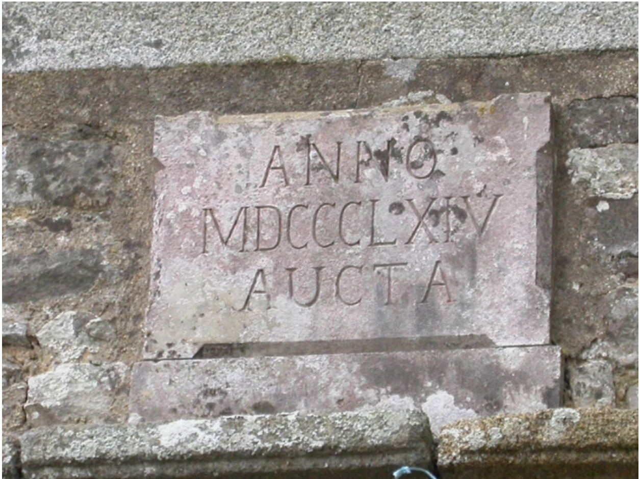
Détail de la plaque située au-dessus de la porte ouest
