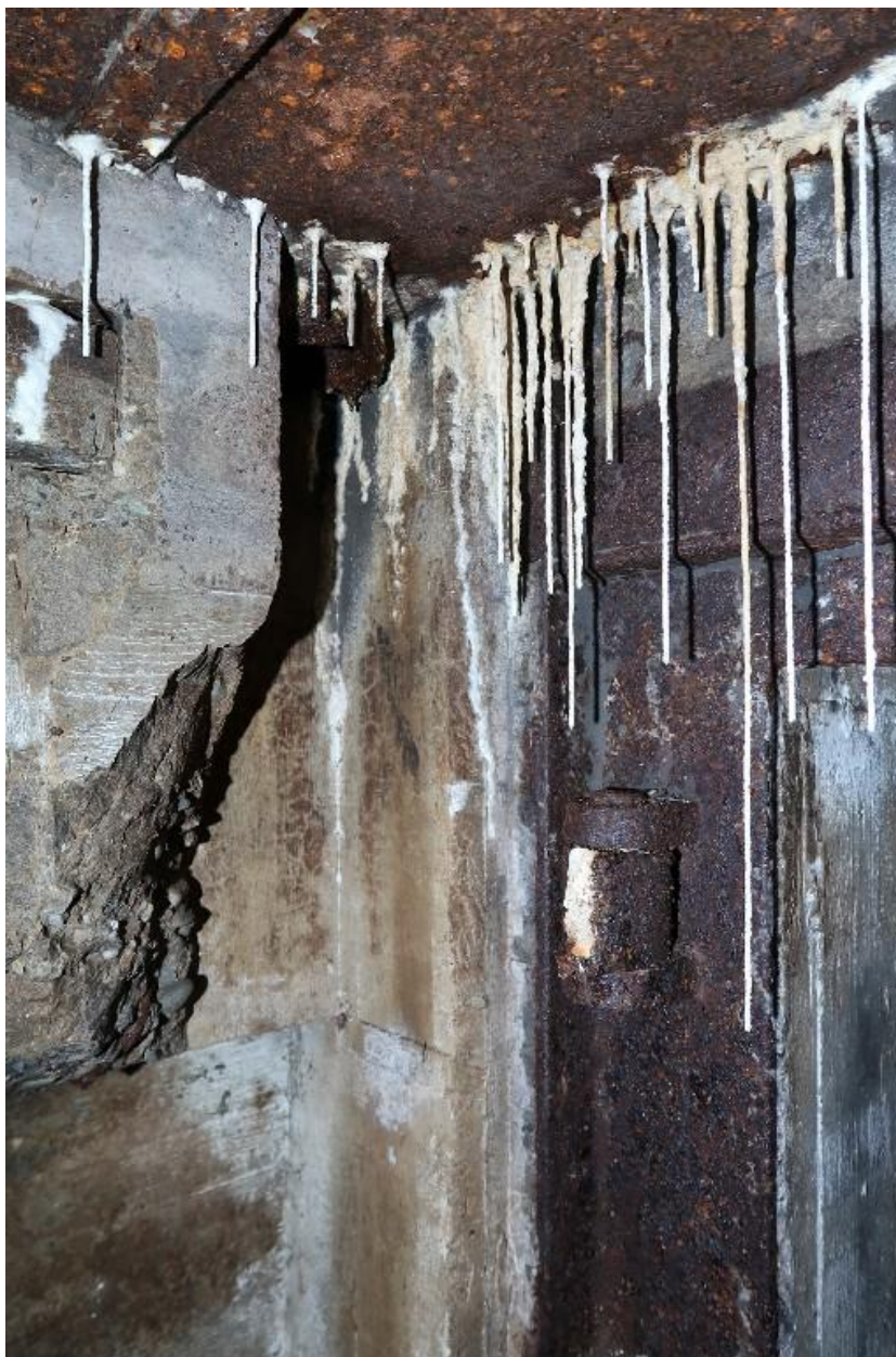
Vue intérieure : détail du puits d'antenne dans le couloir d'entrée nord. A droite, l'hubriserie de la porte blindée
