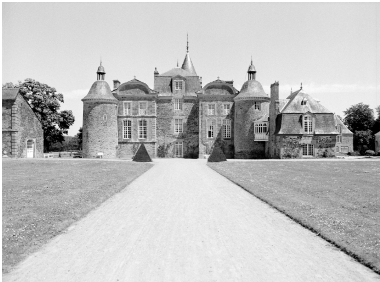
Vue générale ouest
