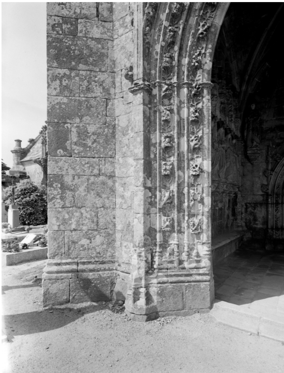
Porche, face sud : baie d'entrée, détail de l'embrasure ouest
