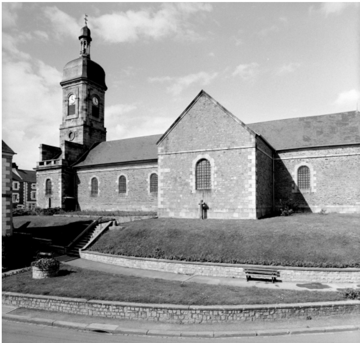
Elévation Sud : vue générale
