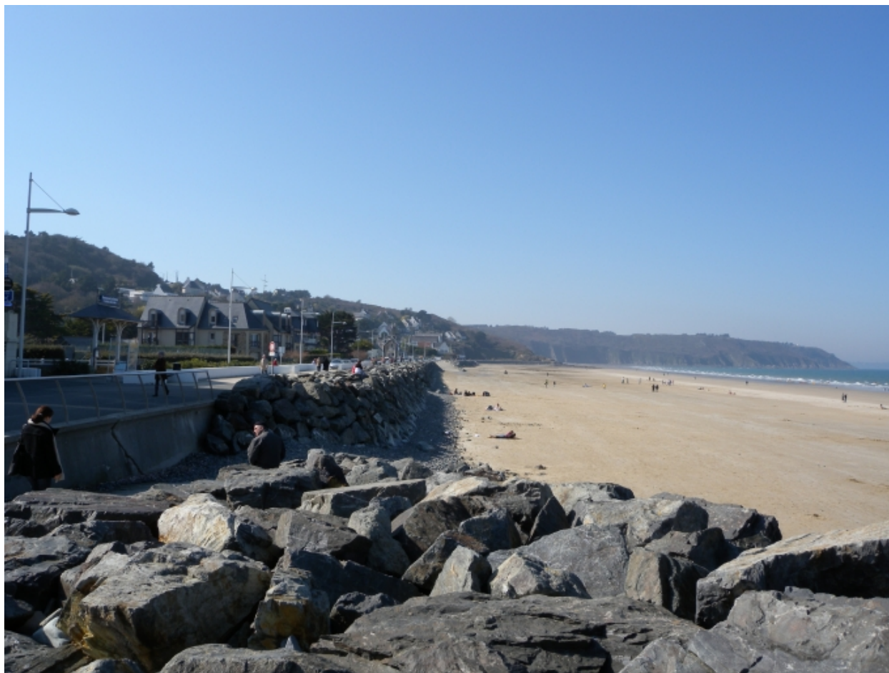
Vue des enrochements devant la digue-promenade
