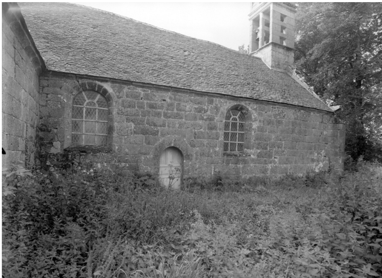
Vue extérieure du mur nord de la nef
