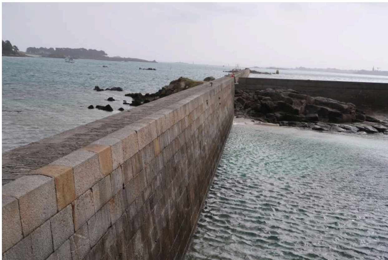
Vue du môle et de la digue SNSM
