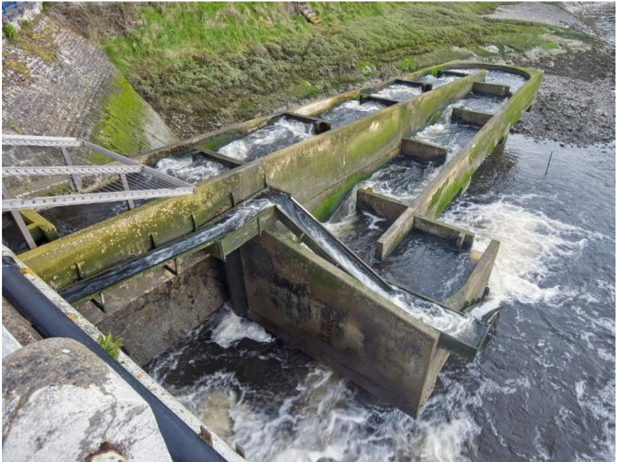
La passe à poissons depuis le pont-déversoir du bassin à flot
