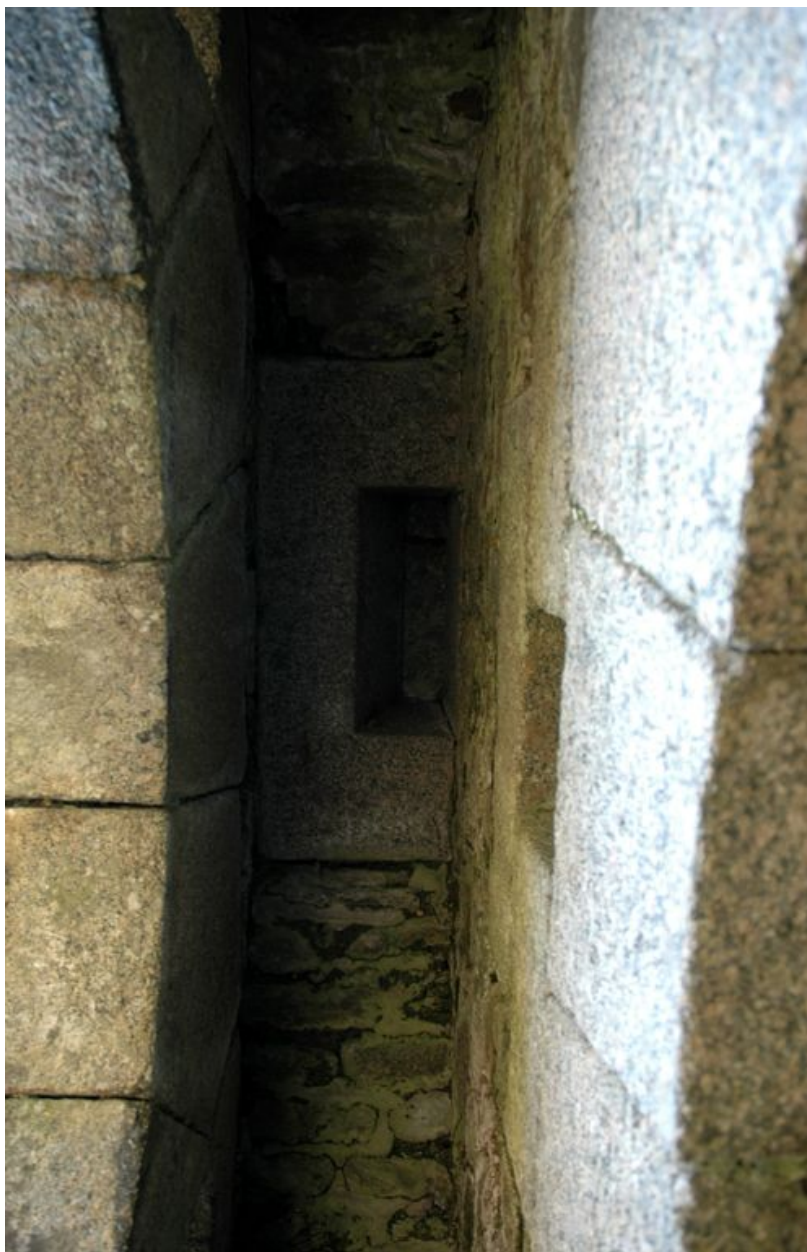
Vue de détail de l'entrée : assommoir ou créneau vertical (état en 2006)
