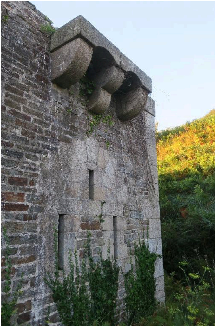
Locmaria, Grands Sables, batterie de La Ferrière, corps de garde crénelé, détail de la façade ouest.
