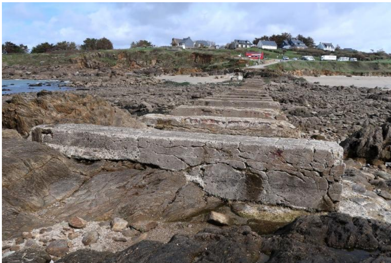
Vue des vestiges de la passerelle
