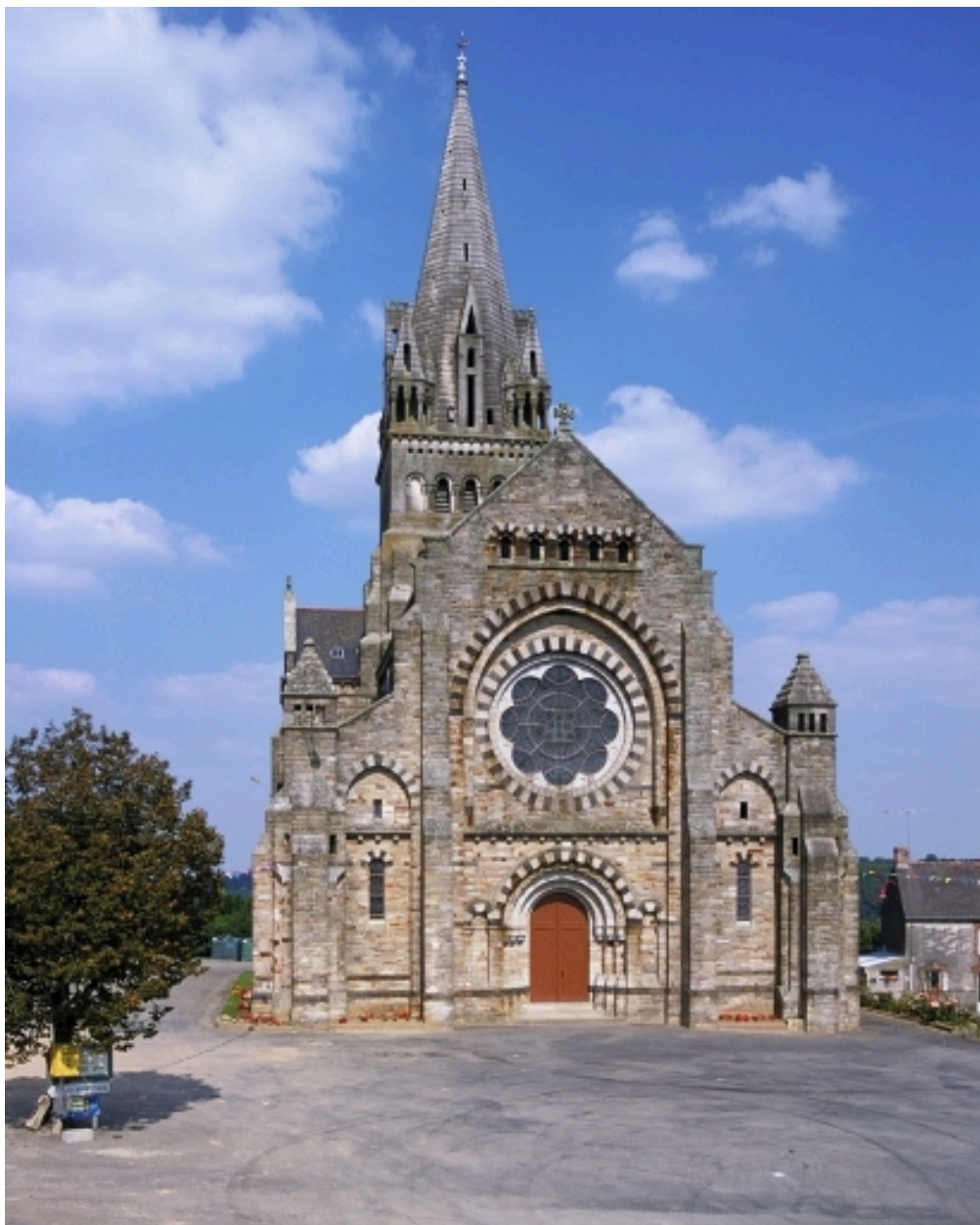
Vue générale ouest
