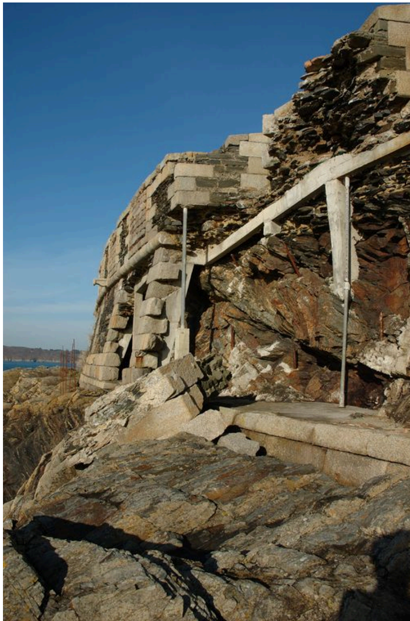
Vue de la batterie de Cornouaille : détail de l'escarpe (mur de soutènement de la batterie). Encadrement des créneaux, et cordon en granite ; remplissage en moellons de schiste (Travaux de stabilisation réalisés par la Direction des Travaux Maritimes)
