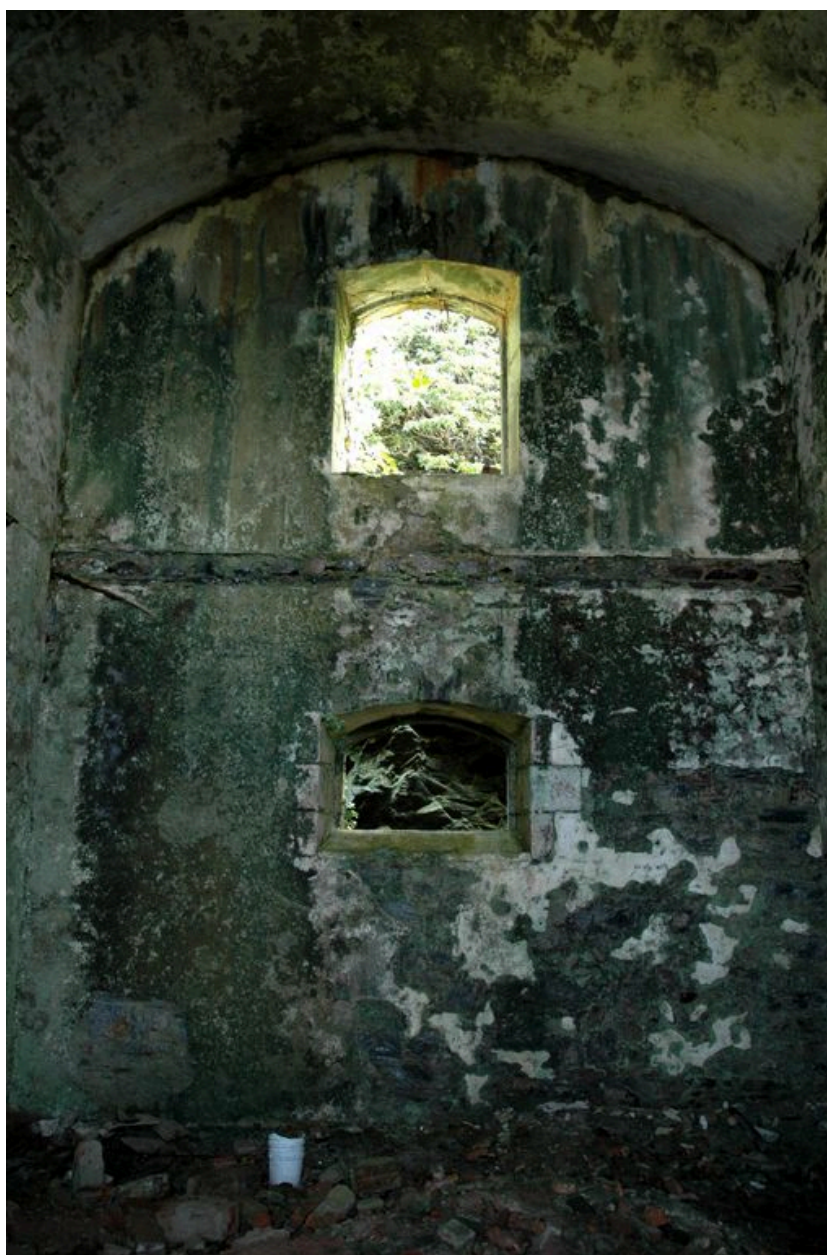
Vue de la caserne défensive Robert : première salle voûtée
