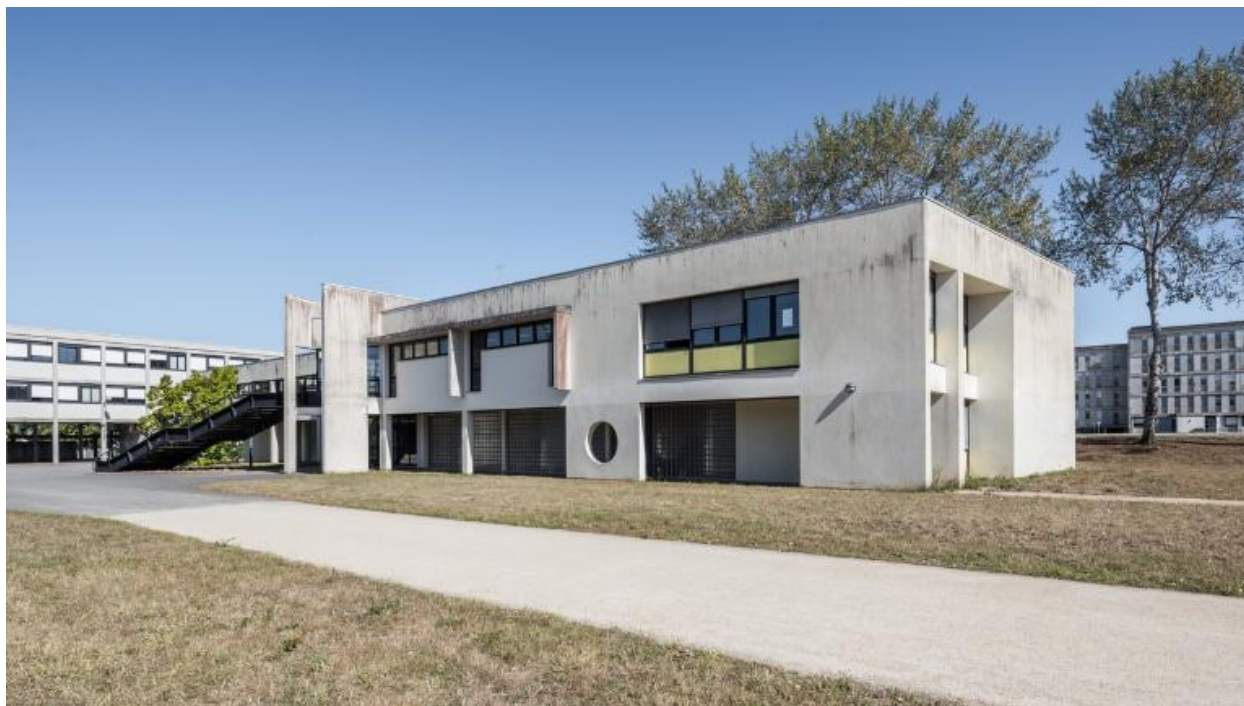
Façade ouest du CDI (François Paumier, architecte, 1990). A l'arrière plan, à gauche, préau du bâtiment B, à droite, bâtiment D.
