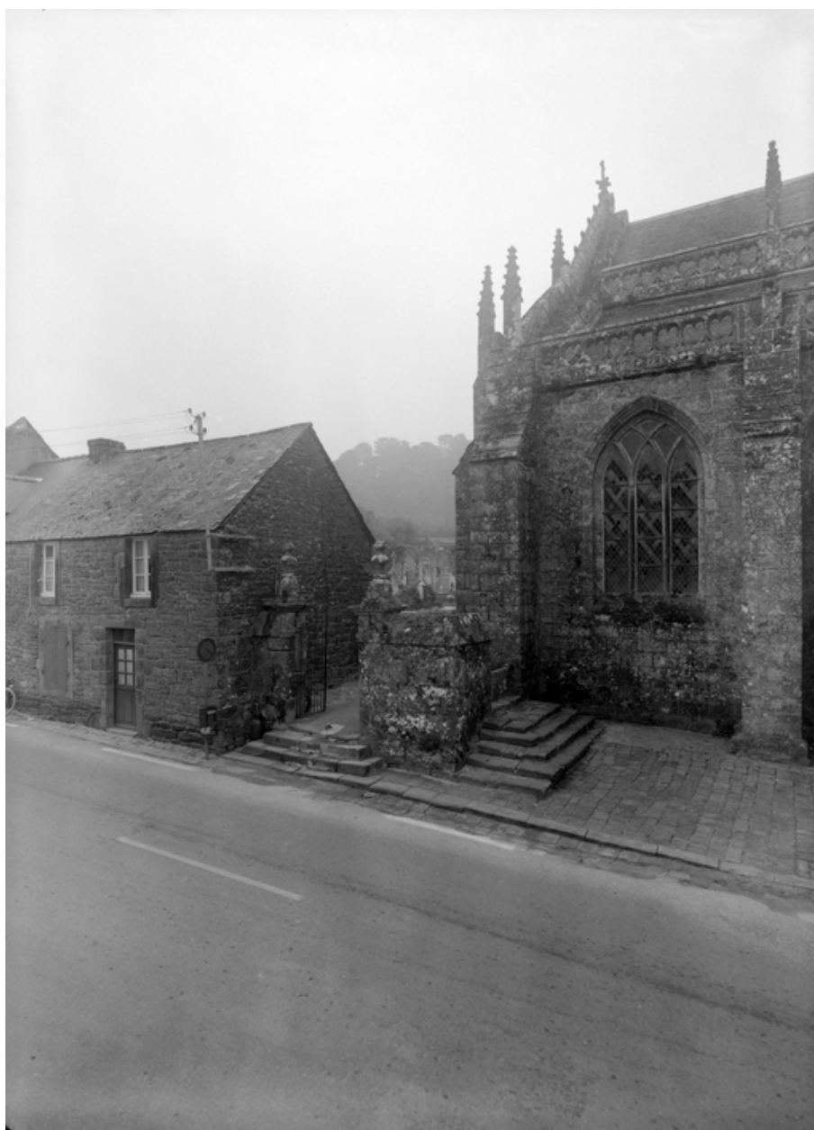
Façade nord, entrée du placitre
