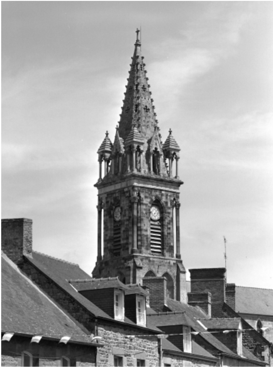
Elévation Sud-Ouest, clocher, partie haute : vue générale
