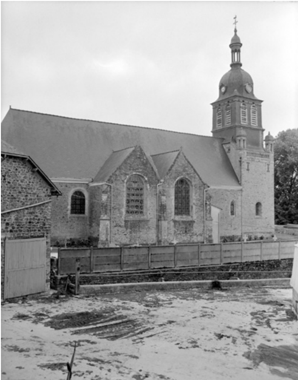
Elévation nord, partie ouest
