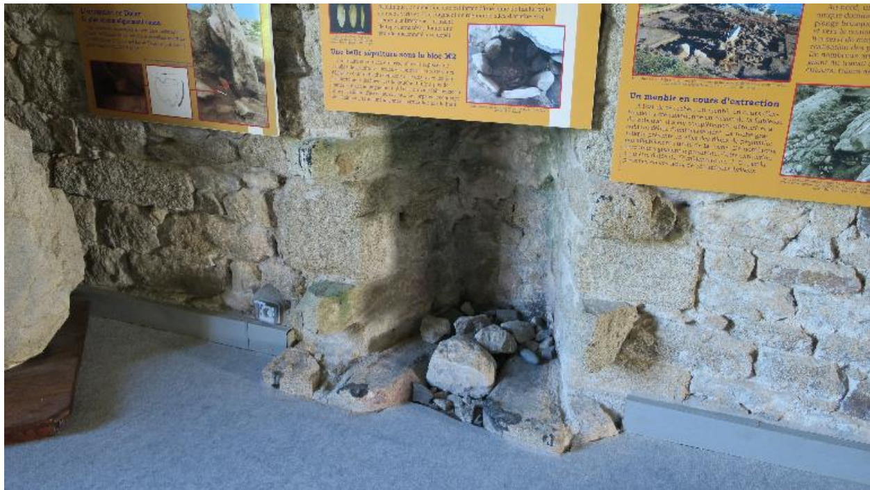
Hoedic, fort central, caserne à l'épreuve, logement du commandant, cheminée.
