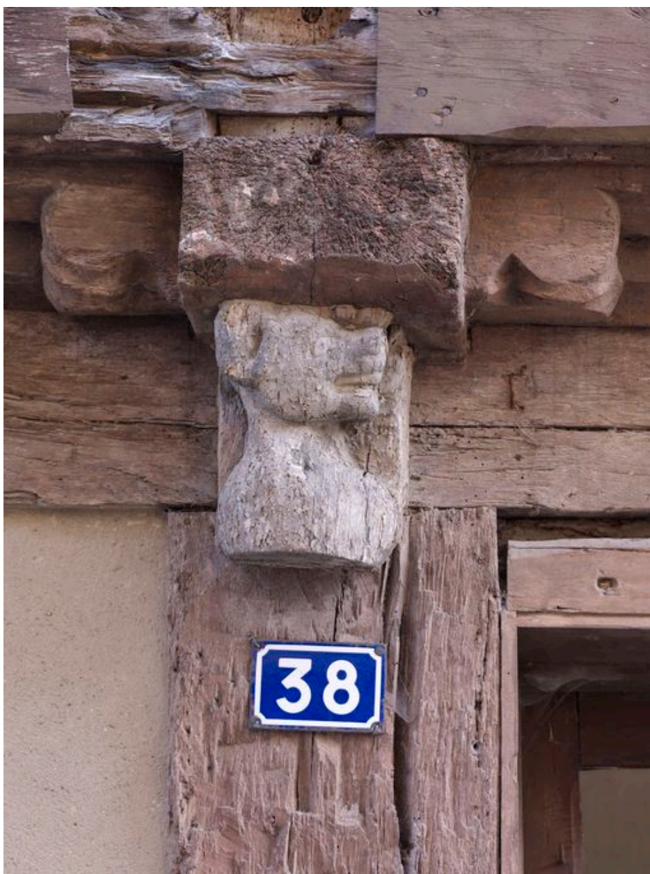
Elévation sud, rez-de-chaussée, décor du poteau d'huisserie : tête de chien (état en 2012)
