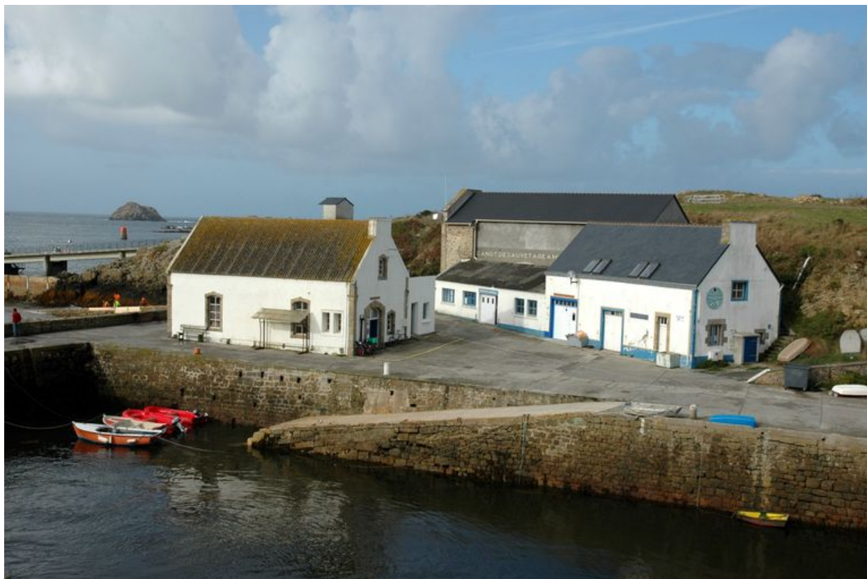
Vue du port-abri de Lampaul
