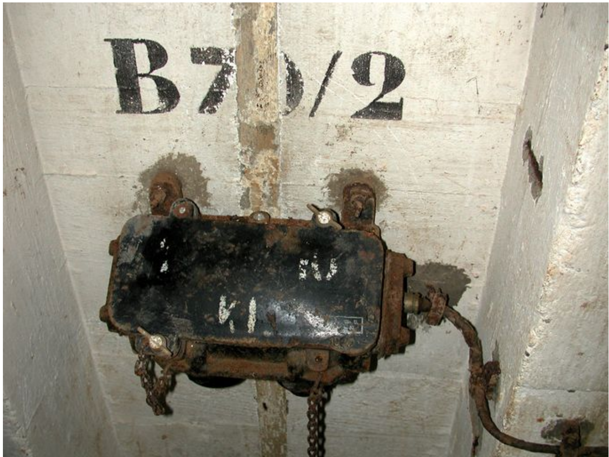
Vue du boîtier de connexion téléphonique - en position fermé - surmonté du marquage B 70/2
