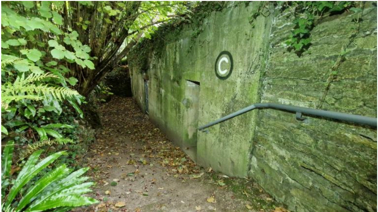
Vue du bunker-abri de type 621 pour un groupe de combat : élévation sud. La première porte dessert le poste d'observation dit Tobruk
