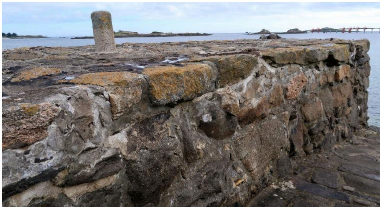
Cale du Vil, ancien embarcadère : détail maçonnerie et pierre d'amarrage
