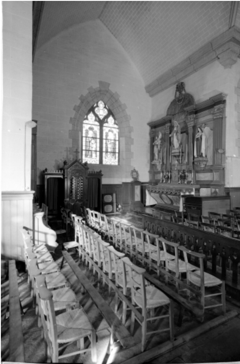
Intérieur, bras du transept nord.
