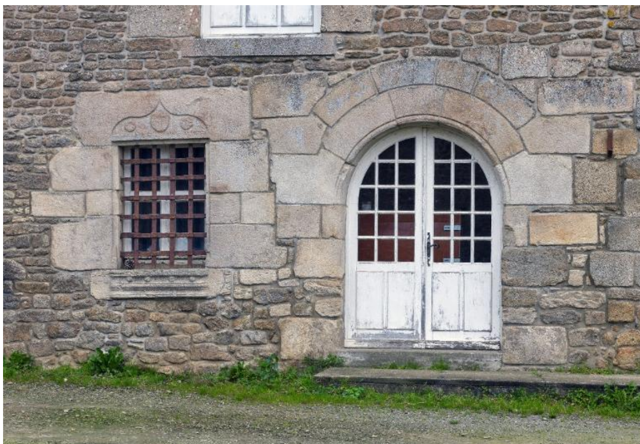
Façade est. Porte et fenêtre de la chambre basse
