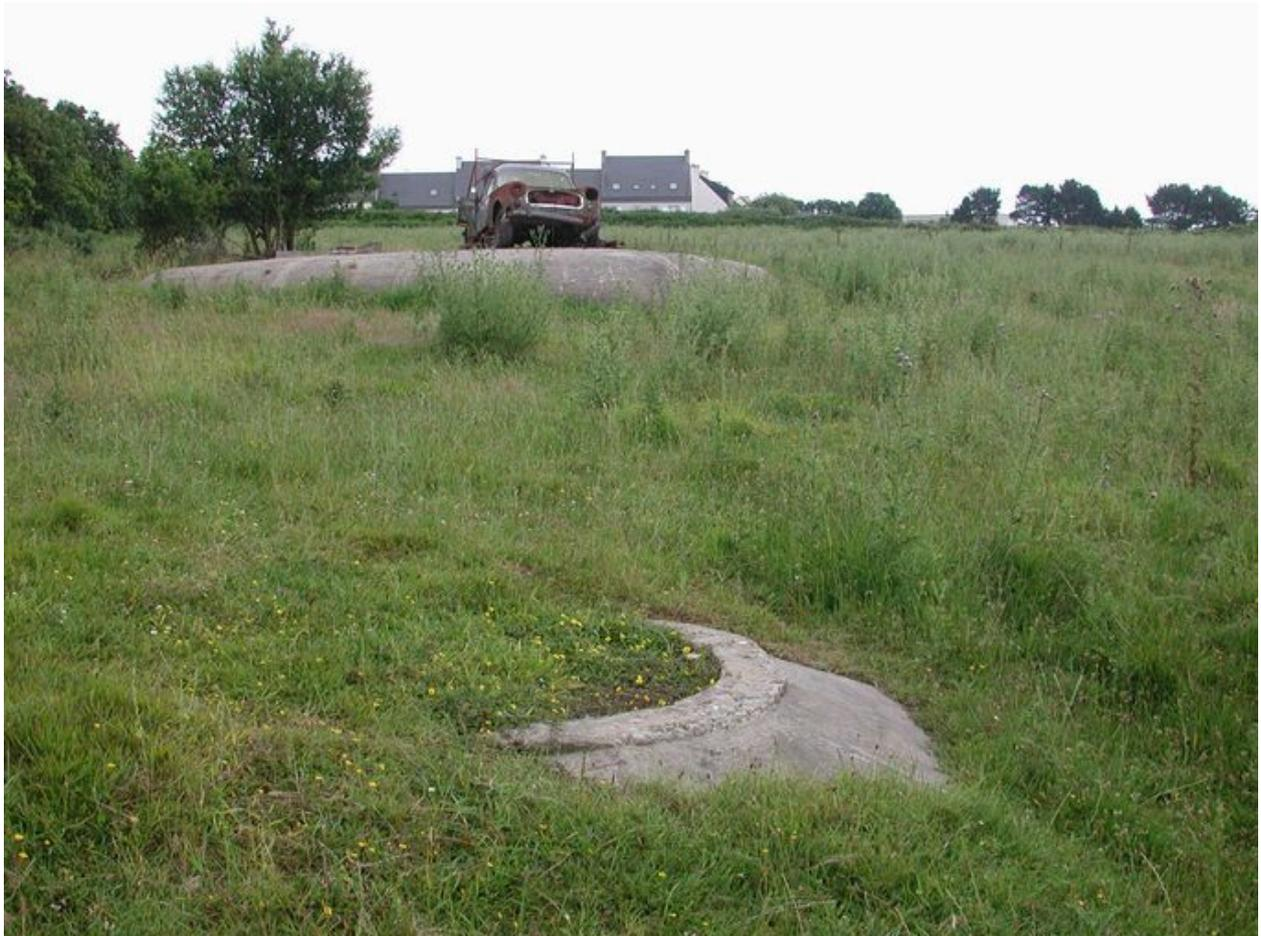
Vue de bunkers dans le secteur de Keranroux (rue Fontaine Margot) : au premier plan, poste d'observation et de mitrailleuse dit Tobrouk, à l'arrière plan, bunker de type 501
