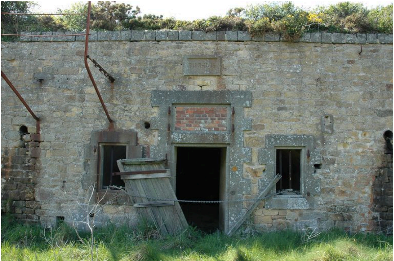
Vue d'une traverse-abri datée de 1883-1884 (état en 2005)
