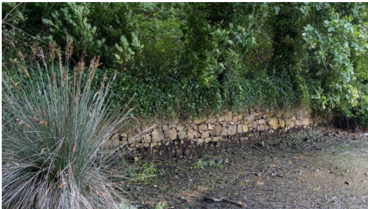
Mur de soutènement caché dans une petite anse du Jaudy au niveau de Kerautret
