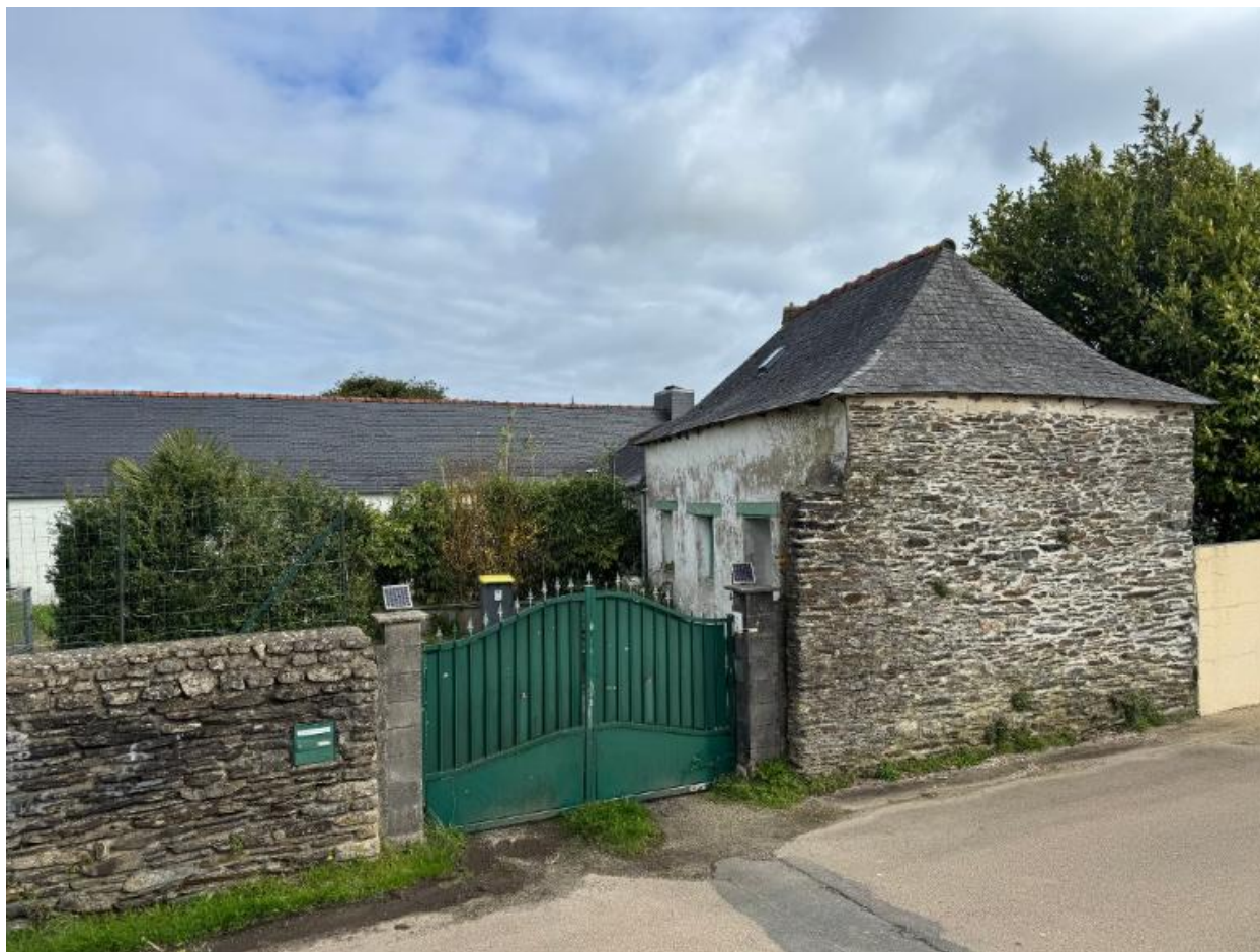
Maison du contremaître. Vue générale
