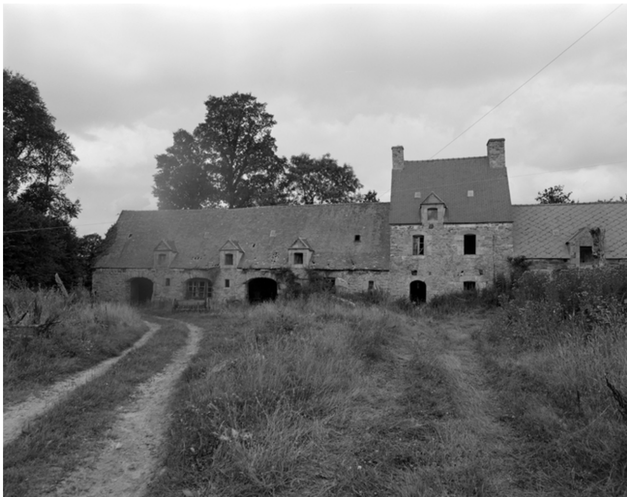
Communs : vue générale
