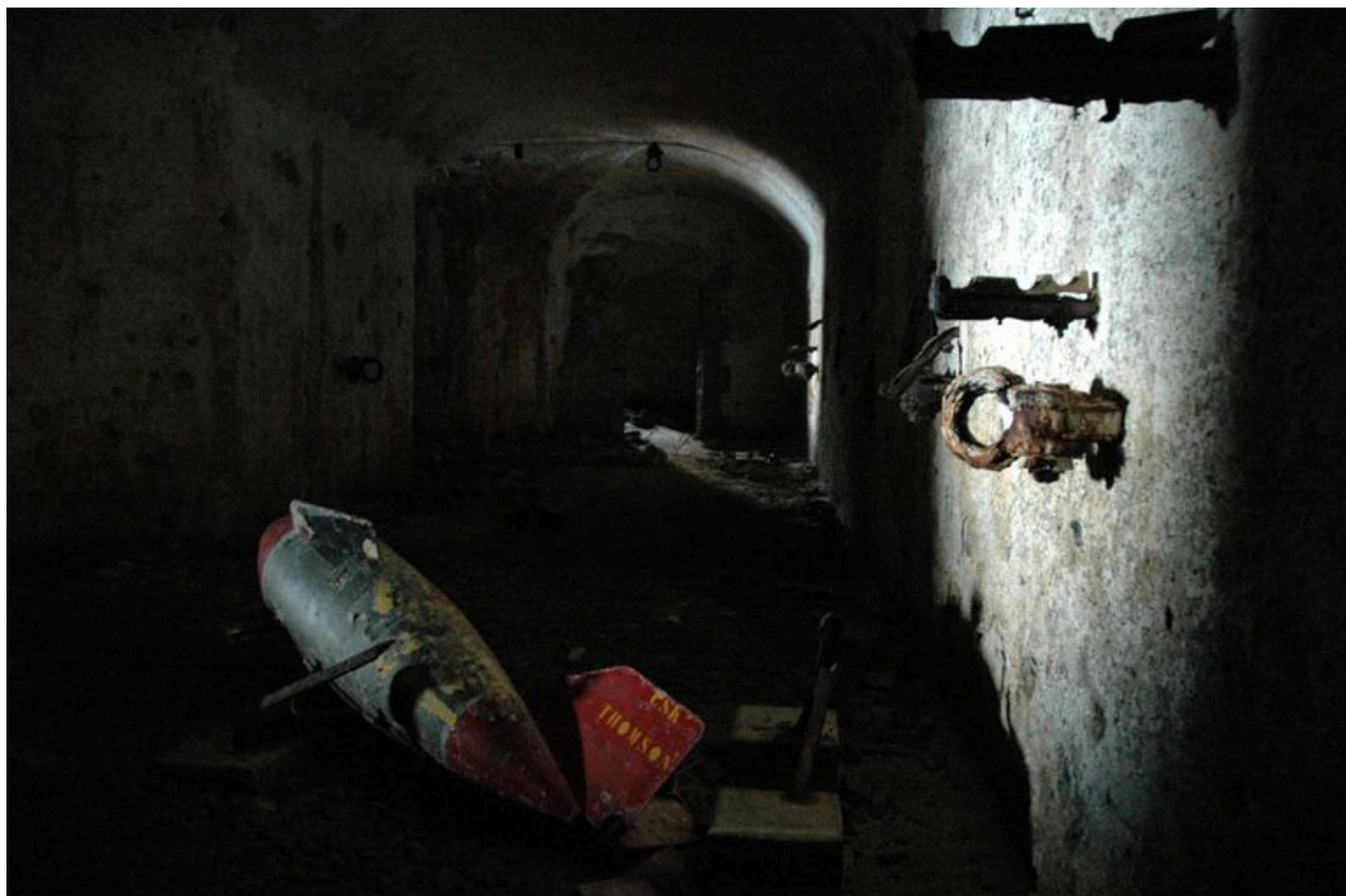
Vue intérieure (état en 2005). Au sol, un flotteur / réservoir ayant servi à un exercice militaire
